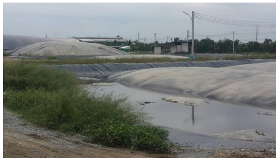
รูปบ่อรับน้ำเสีย และจุดที่ถ่ายน้ำเสียจากรถบรรทุกเข้าบ่อ
