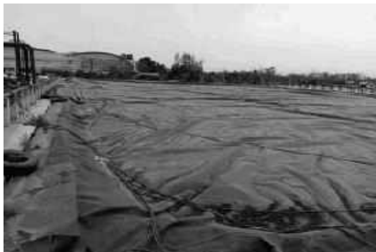
บ่อพักน้ำเสีย (Wastewater Pond)
